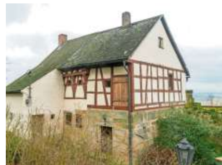
Das Glockenhaus in Gesees.
